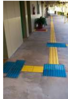
Sinalização do piso corredores
