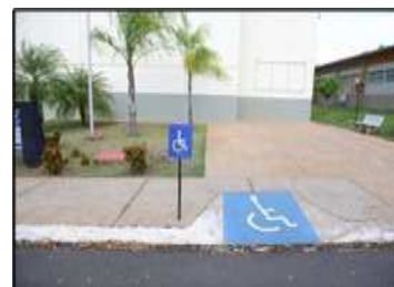
Rampa de acesso
