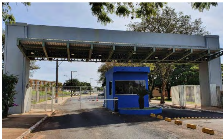
Nova Portaria da FEMA (em construção) Entrada Av. Getúlio Vargas (principal)
