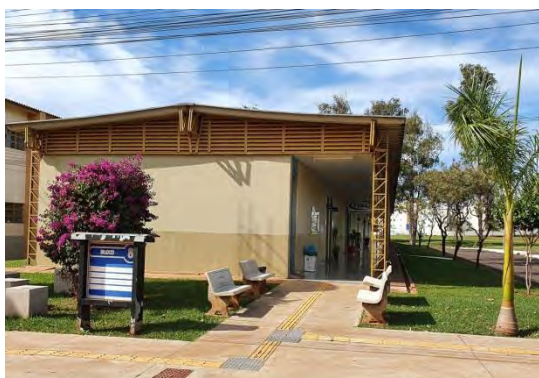
Rampa de acesso aos blocos
