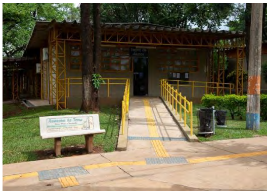
Rampa de acesso aos blocos
