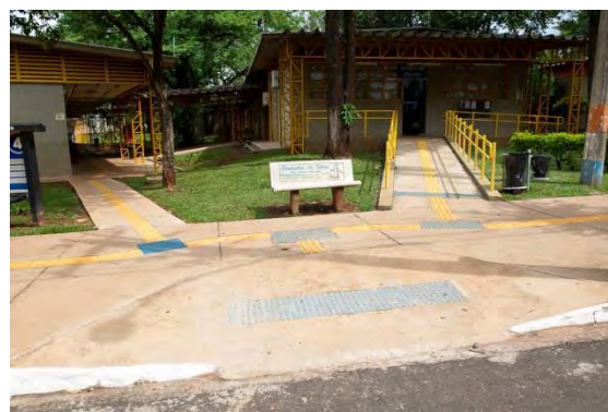
Rampa de acesso aos blocos
