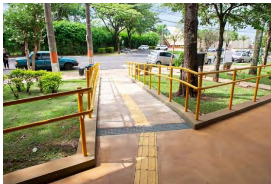
Rampa de acesso aos blocos
