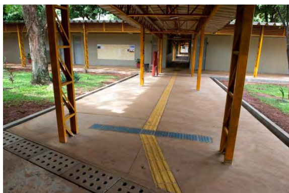
Corredores dos blocos
