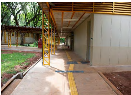
Corredores dos blocos
