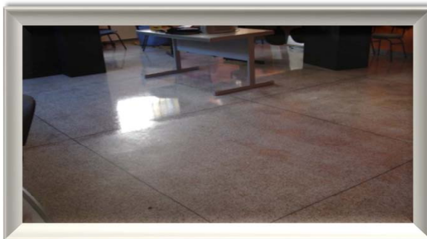
(Piso com seladora na parte inferior e após tratamento completo na parte superior da foto)
