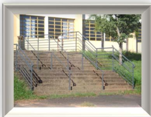
(Instalação de corrimãos nas escadarias do bloco 9 – Projeto de Incêndio)
