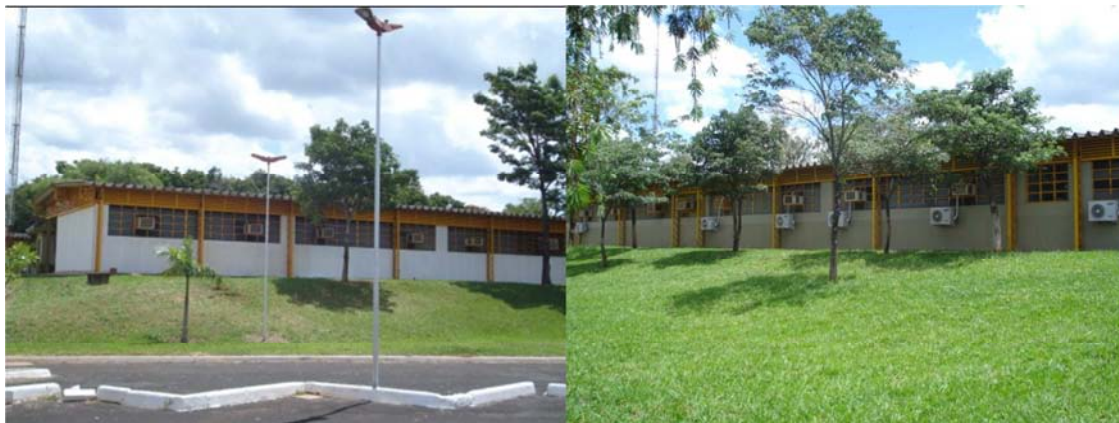
(Bloco 7 - pintura em andamento)
