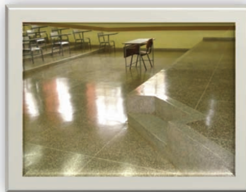
(Bloco 10 – piso tratado)
