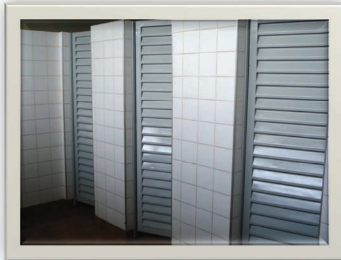
(Pintura das portas existentes nos banheiros da instituição)
